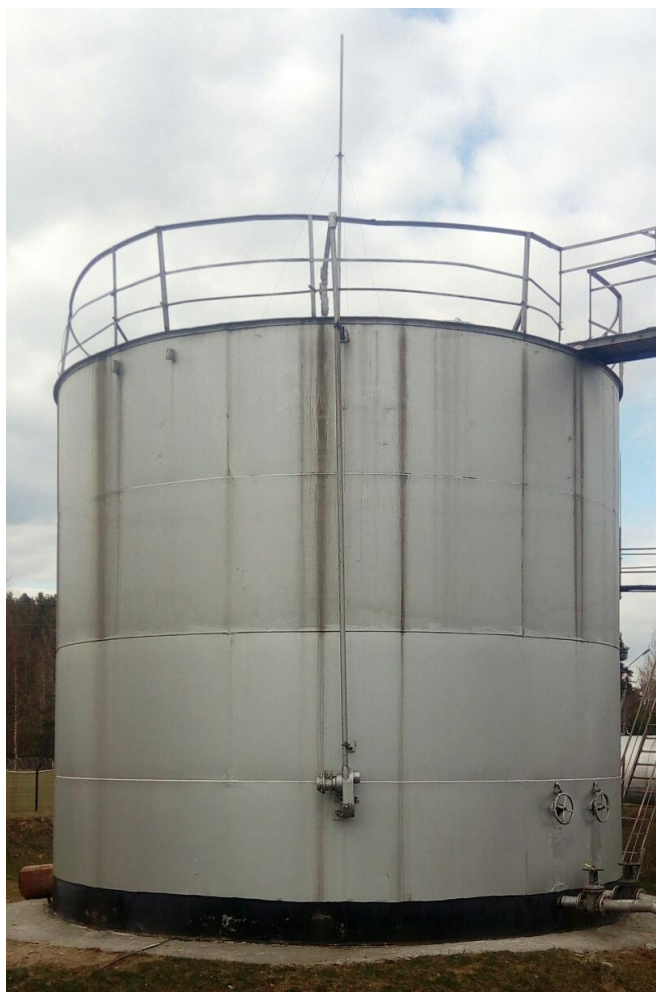
Рисунок 1 - Общий вид резервуара стального вертикального цилиндрического РВС-200
