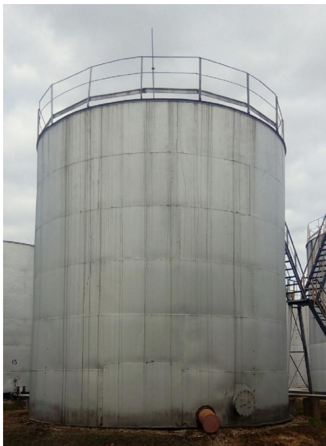
Рисунок 2 - Общий вид резервуара стального вертикального цилиндрического РВС-400
