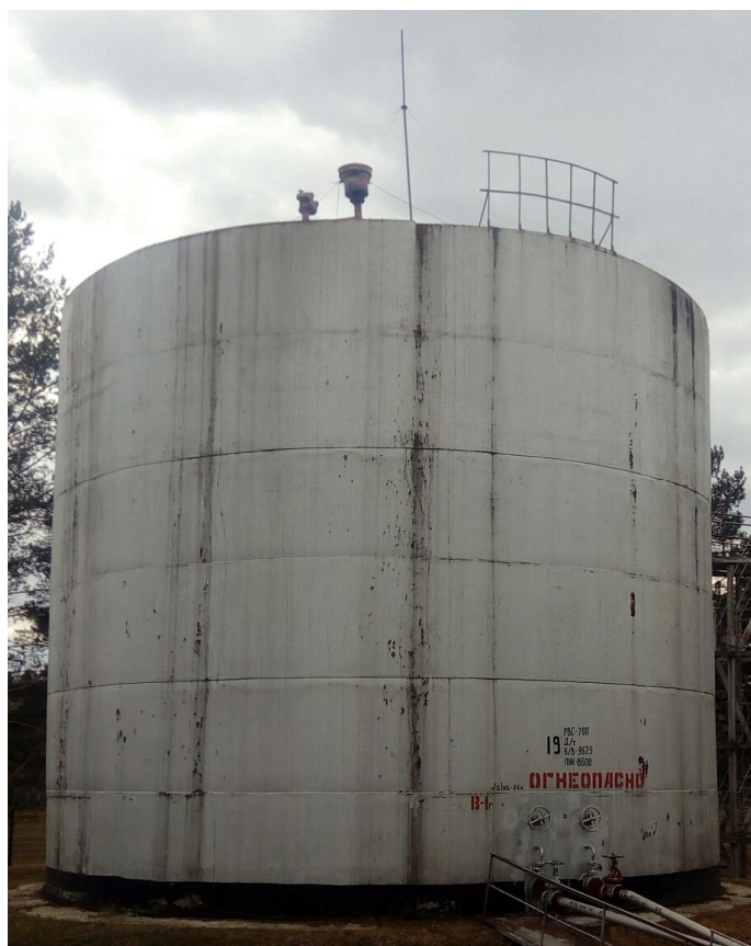
Рисунок 3 - Общий вид резервуара стального вертикального цилиндрического РВС-700
