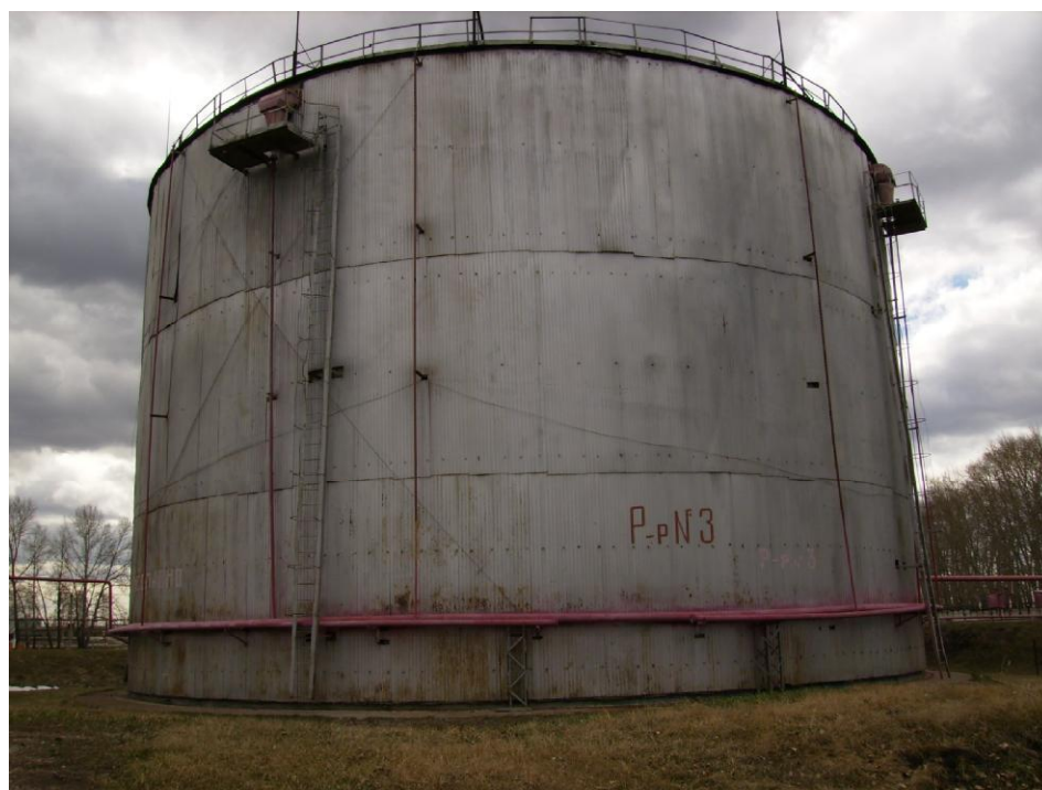
Рисунок 1 - Общий вид резервуара стального вертикального цилиндрического РВС-10000 № 3
