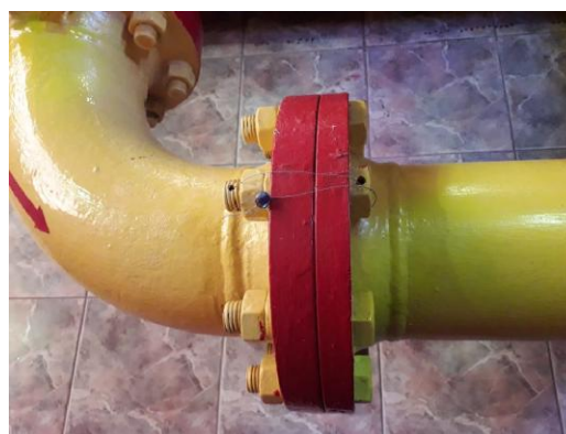
Рисунок 2 – Схема пломбировки фланцевых соединений измерительного участка установки трубопоршневой поверочной стационарной «Прувер С-100-4,0-0,05»
