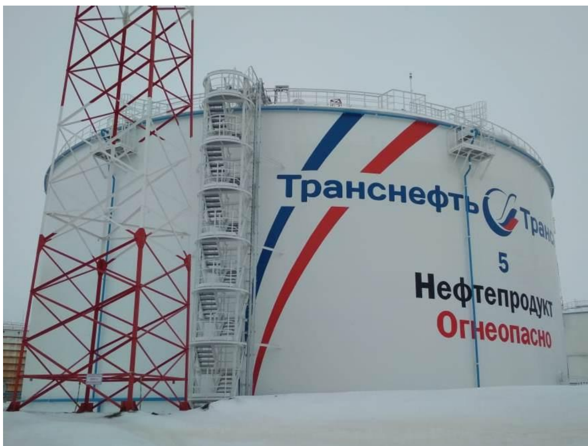
Рисунок 1 - Общий вид резервуара стального вертикального цилиндрического РВСП-20000
