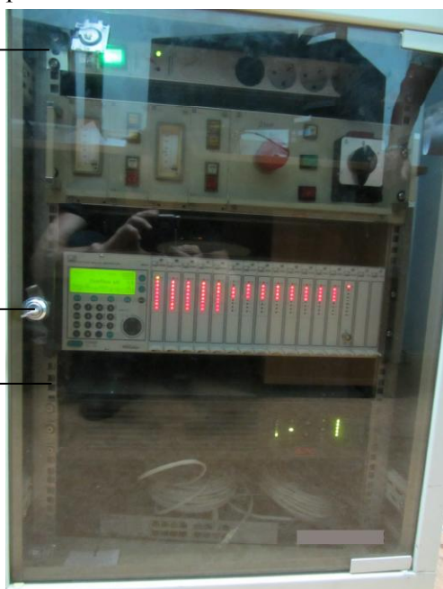
Рисунок 4 – Стойка с модулями для измерений линейных перемещений
