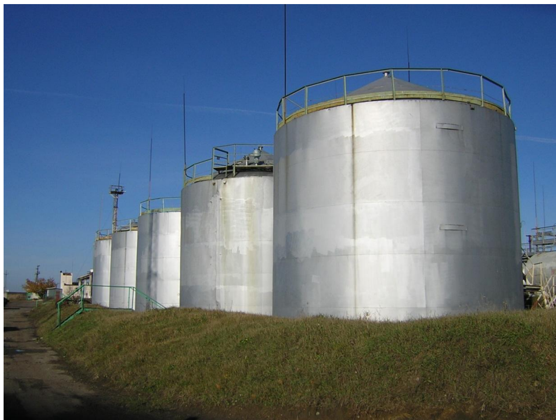
Рисунок 1 - Общий вид резервуаров стальных вертикальных цилиндрических РВС-400
