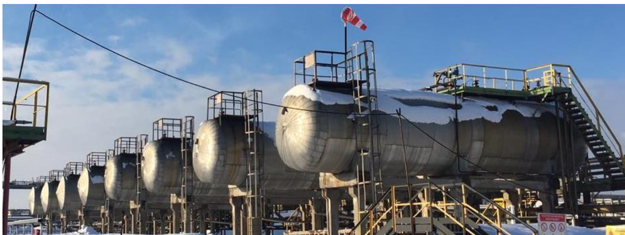
Рисунок 1 - Общий вид резервуара стального горизонтального цилиндрического РГС-100
