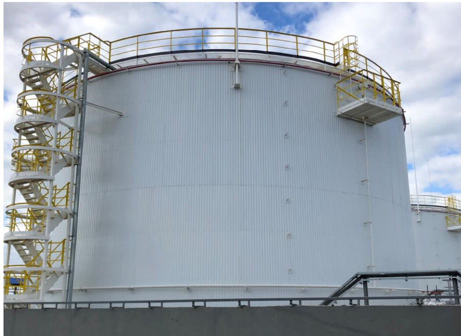
Рисунок 1 - Общий вид резервуара стального вертикального цилиндрического РВС-5000
