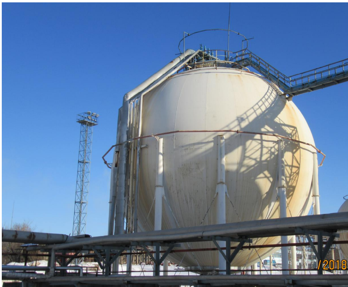
Рисунок 1 - Общий вид резервуаров стальных шаровых РШС-2000
