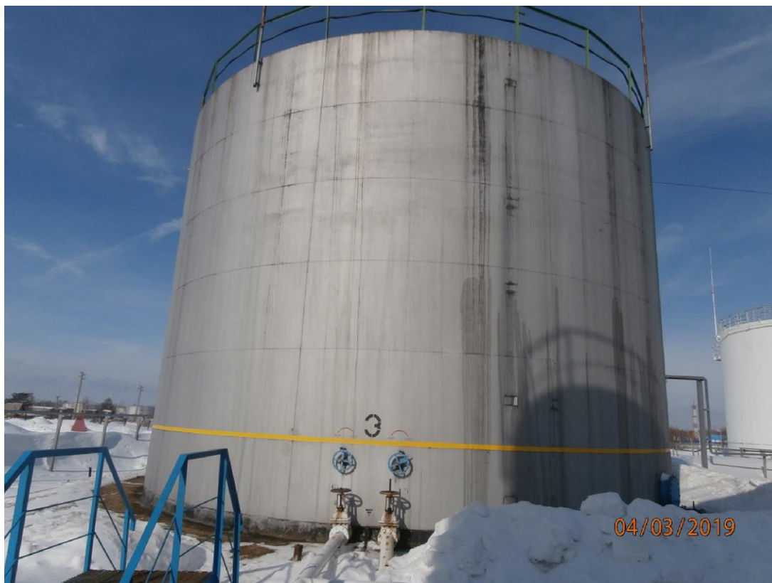
Рисунок 1 - Общий вид резервуара вертикального стального цилиндрического РВС-1000,
