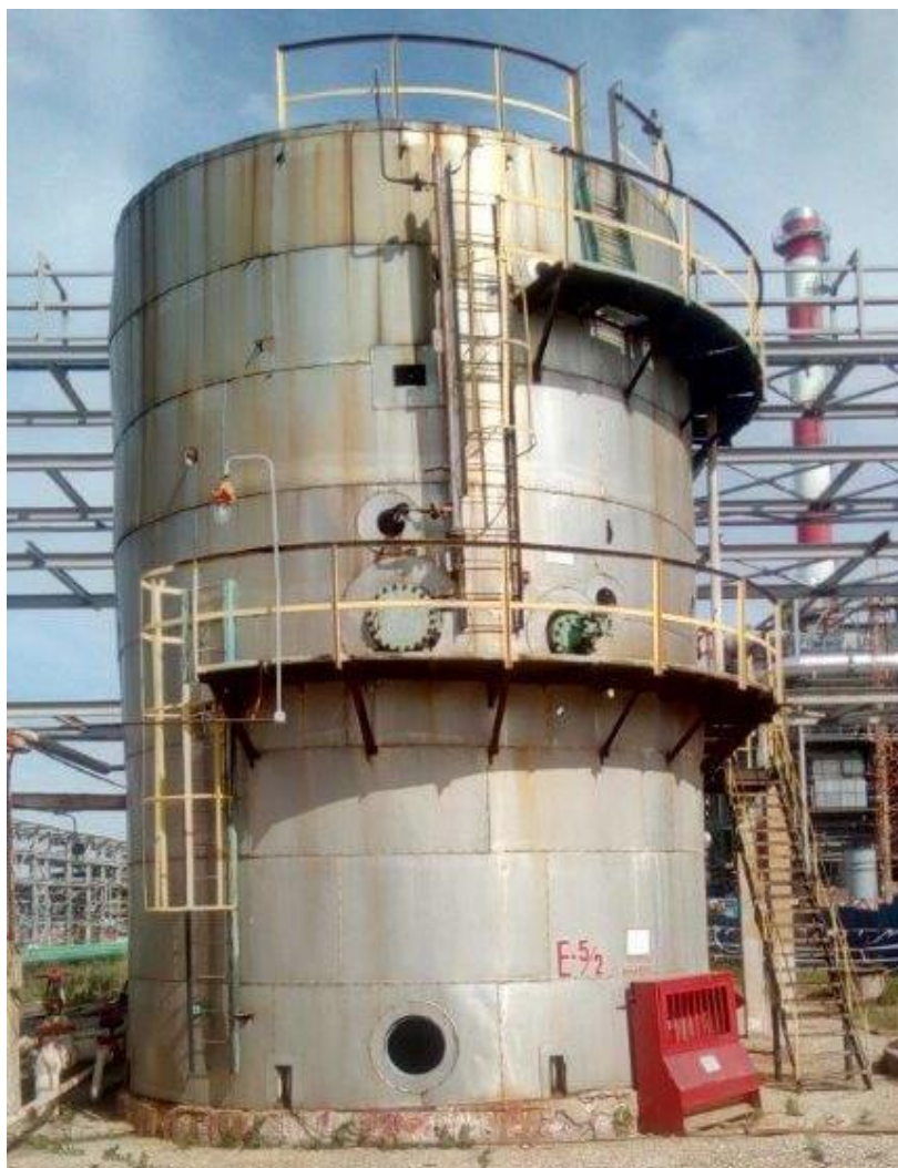
Рисунок 1 - Общий вид резервуара стального вертикального цилиндрического РВС-300
