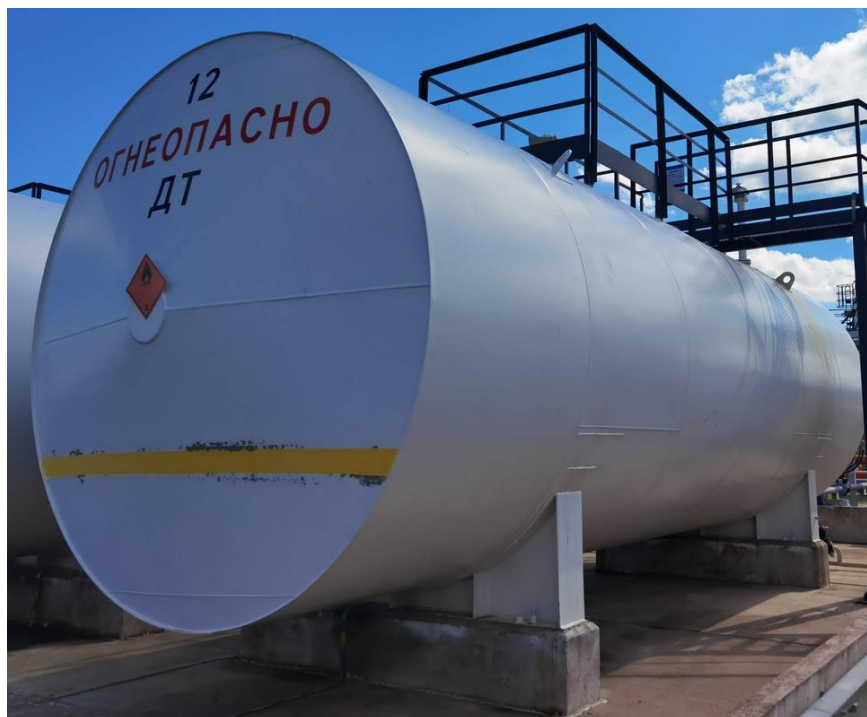
Рисунок 2 – Общий вид резервуаров РГ
