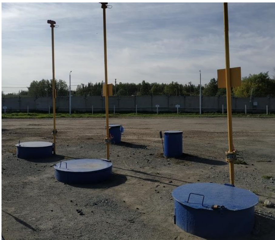
Рисунок 2 – Общий вид резервуаров РГС-10
