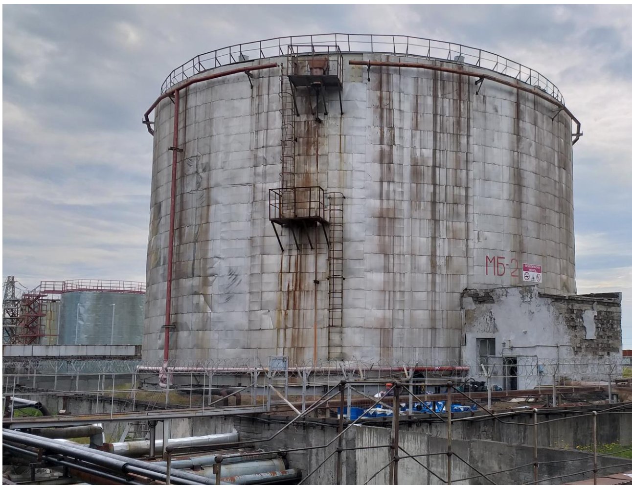
Рисунок 1 – Общий вид резервуара РВС-10000
