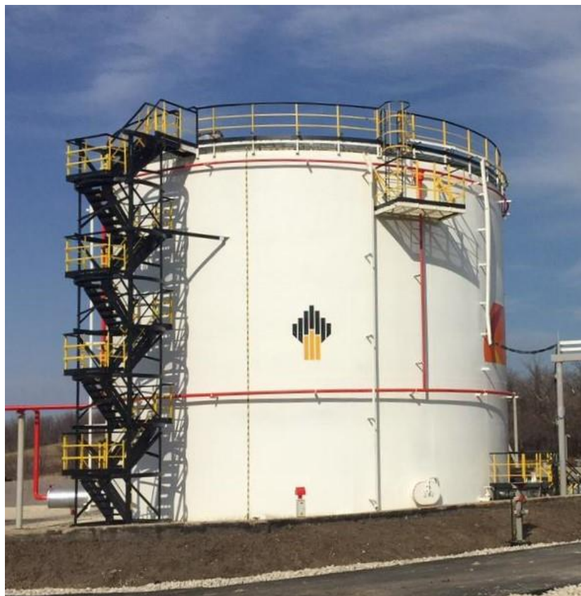
Рисунок 1 – Общий вид резервуара РВС-2000
