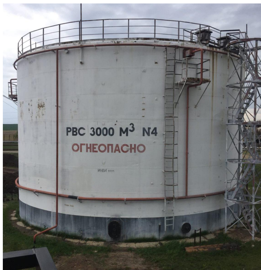
Рисунок 2 – Общий вид резервуаров РВС-3000
