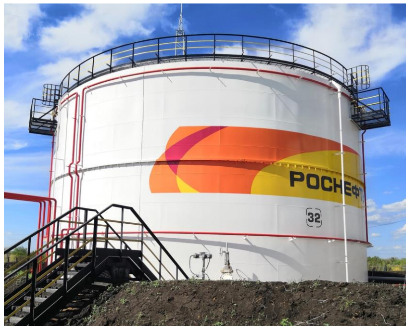
Рисунок 2 – Общий вид резервуаров РВС-5000
