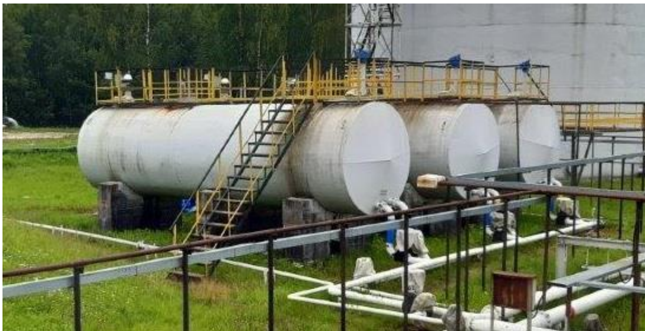
Рисунок 1 – Общий вид резервуаров
