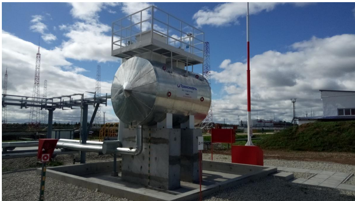
Рисунок 2 – Общий вид резервуара РГС-10
