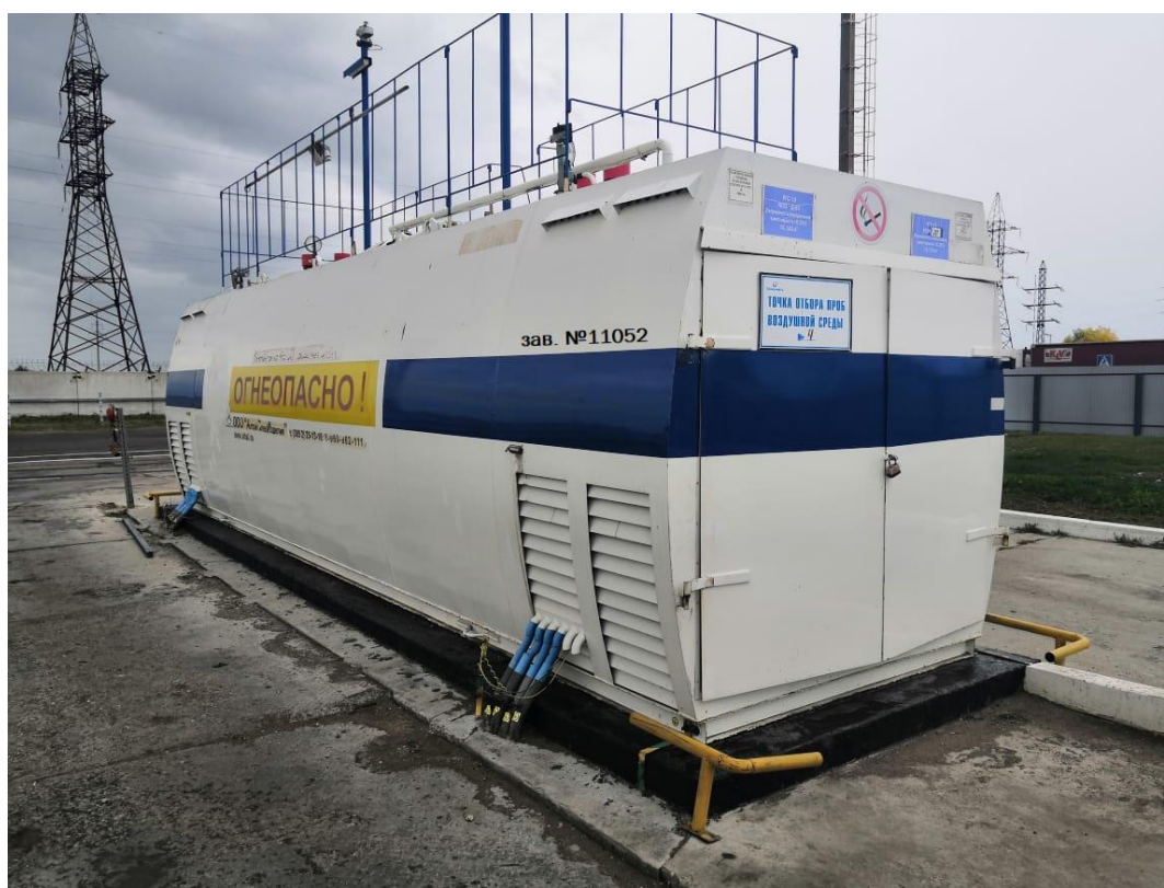
Рисунок 2 – Общий вид резервуара РГС-20 с заводским номером 11052
