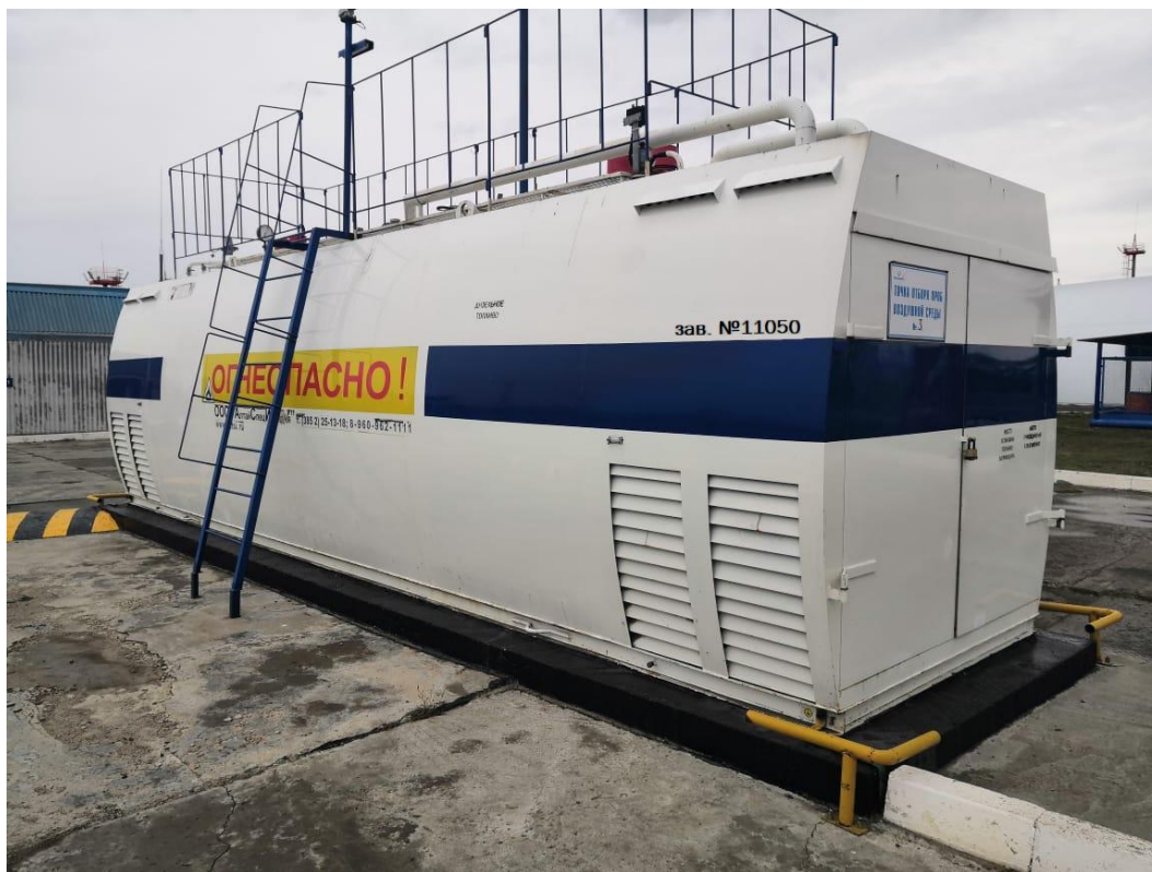
Рисунок 1 – Общий вид резервуара РГС-20 с заводским номером 11050
