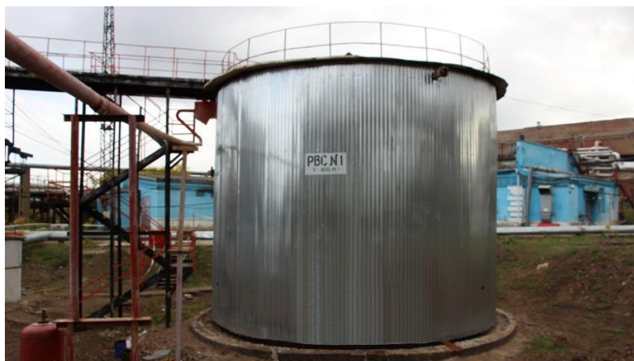
Рисунок 1 – Общий вид резервуара стального вертикального цилиндрического РВС-400 серийный № 1
