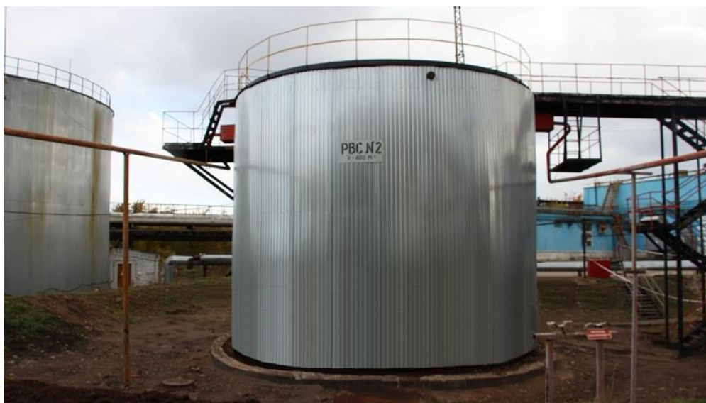
Рисунок 2 – Общий вид резервуара стального вертикального цилиндрического РВС-400 серийный № 2
