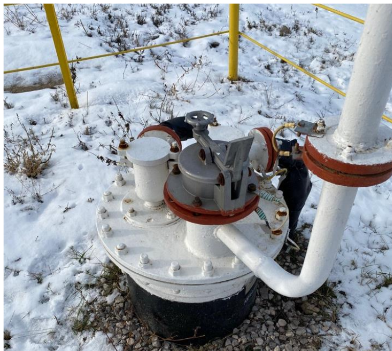
Рисунок 2 – Общий вид резервуара РГС-5
