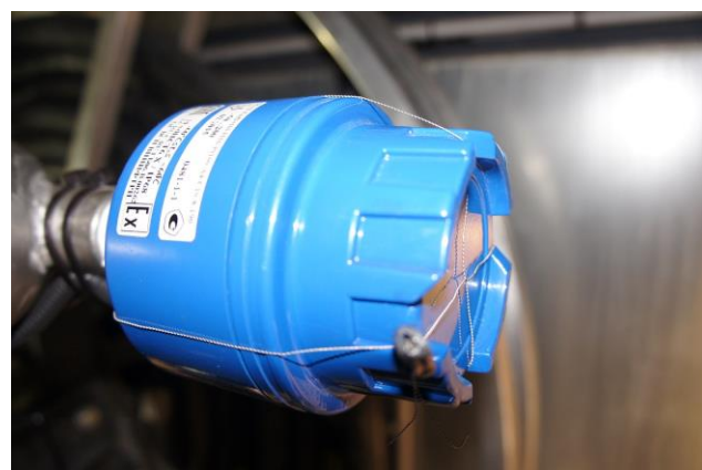
Рисунок 13 – Пломбирование датчика температуры
