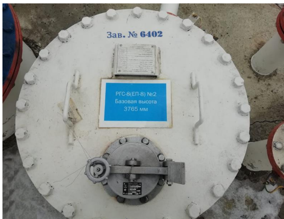
Рисунок 2 – Общий вид резервуара РГС-8 с заводским номером 6402
