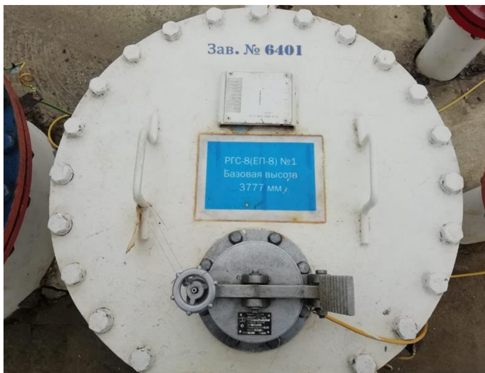
Рисунок 1 – Общий вид резервуара РГС-8 с заводским номером 6401
