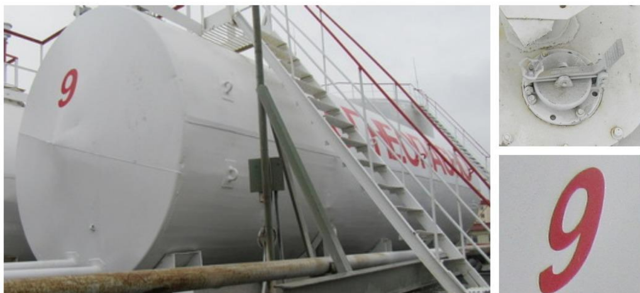
Рисунок 2 – Общий вид резервуара РГС-50 с заводским номером 9
