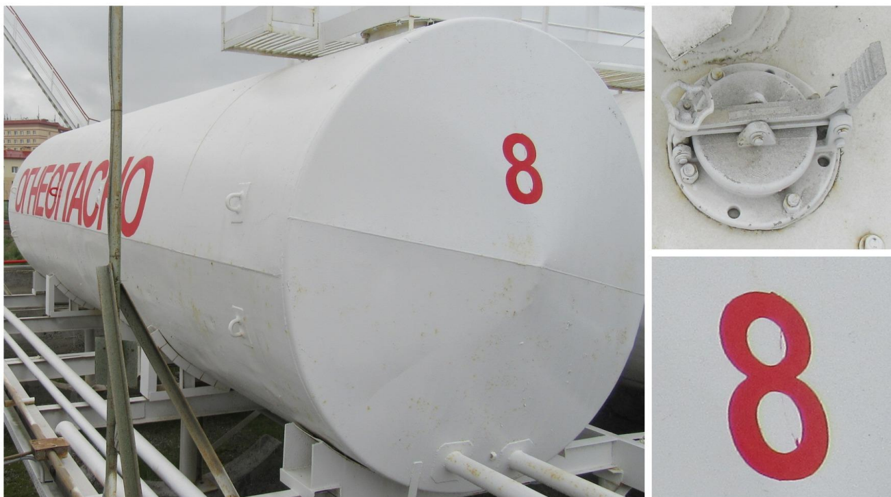
Рисунок 1 – Общий вид резервуара РГС-50 с заводским номером 8
