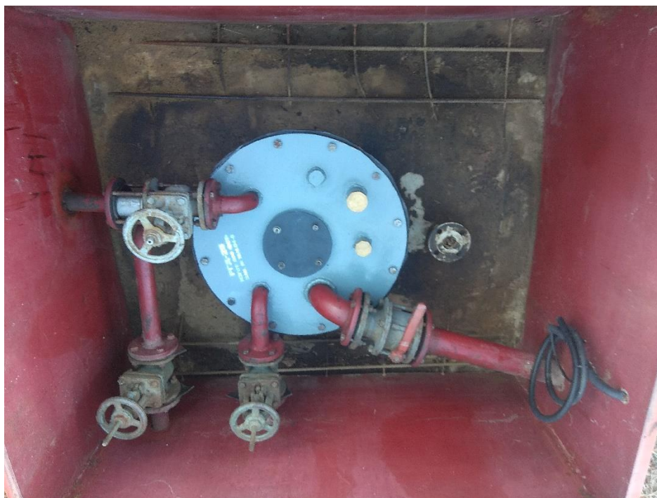
Рисунок 4- Фотография крышки замерного люка резервуара стального горизонтального цилиндрического двустенного РГД-25 заводской номер 19/4.04-03
