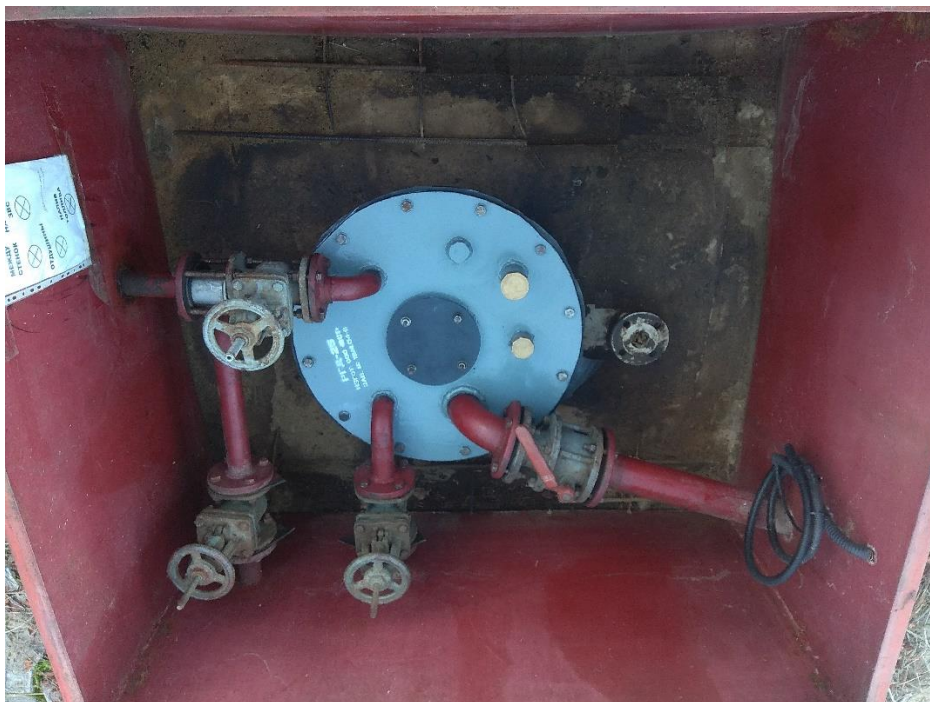
Рисунок 3- Фотография крышки замерного люка резервуара стального горизонтального цилиндрического двустенного РГД-25 заводской номер 19/4.04-02
