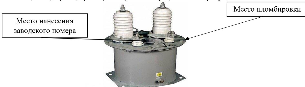
Рисунок 1 – Общий вид средства измерений и место пломбировки от несанкционированного доступа
