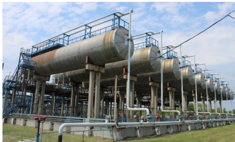
Рисунок 1 – Общий вид резервуаров
