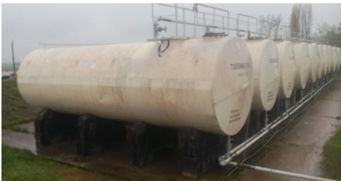
Рисунок 1 – Общий вид резервуаров РГС-50
