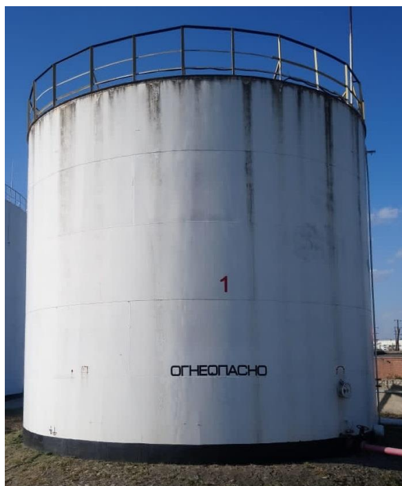
Рисунок 1 – Общий вид резервуаров РВС-400
