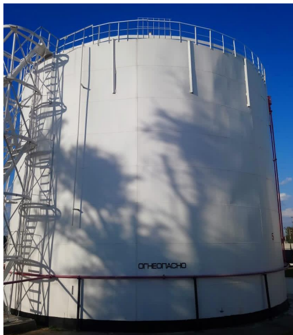
Рисунок 2 – Общий вид резервуаров РВС-2000
