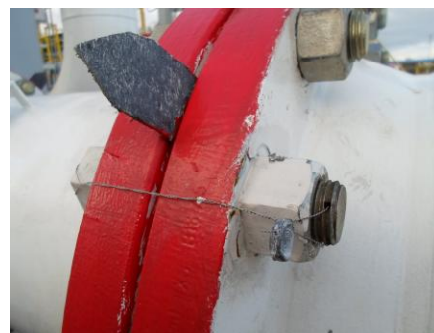
Рисунок 2 - Места установки пломб на ТПР
