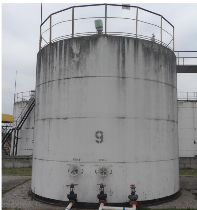
Рисунок 1 – Общий вид резервуаров РВС-200
