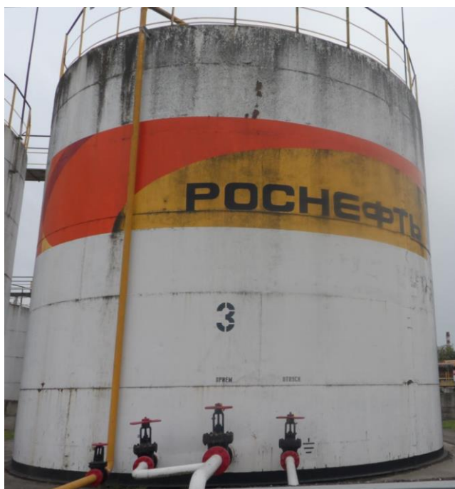
Рисунок 2 – Общий вид резервуаров РВС-400
