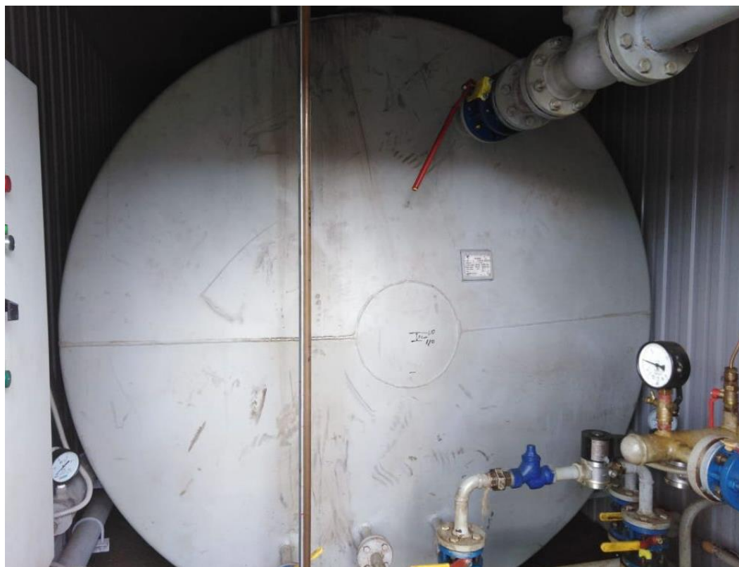
Рисунок 2 – Общий вид резервуаров Р-25
