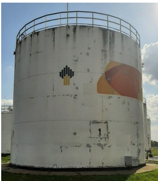
Рисунок 3 – Общий вид резервуаров РВС-700
