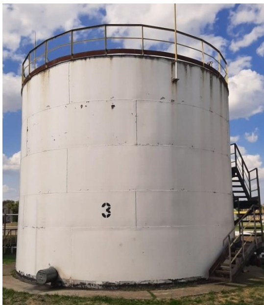
Рисунок 2 – Общий вид резервуаров РВС-400
