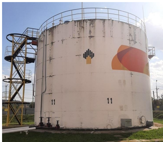
Рисунок 4 – Общий вид резервуара РВС-1000
