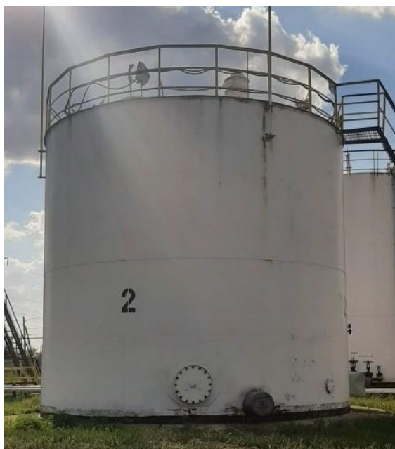
Рисунок 1 – Общий вид резервуаров РВС-200
