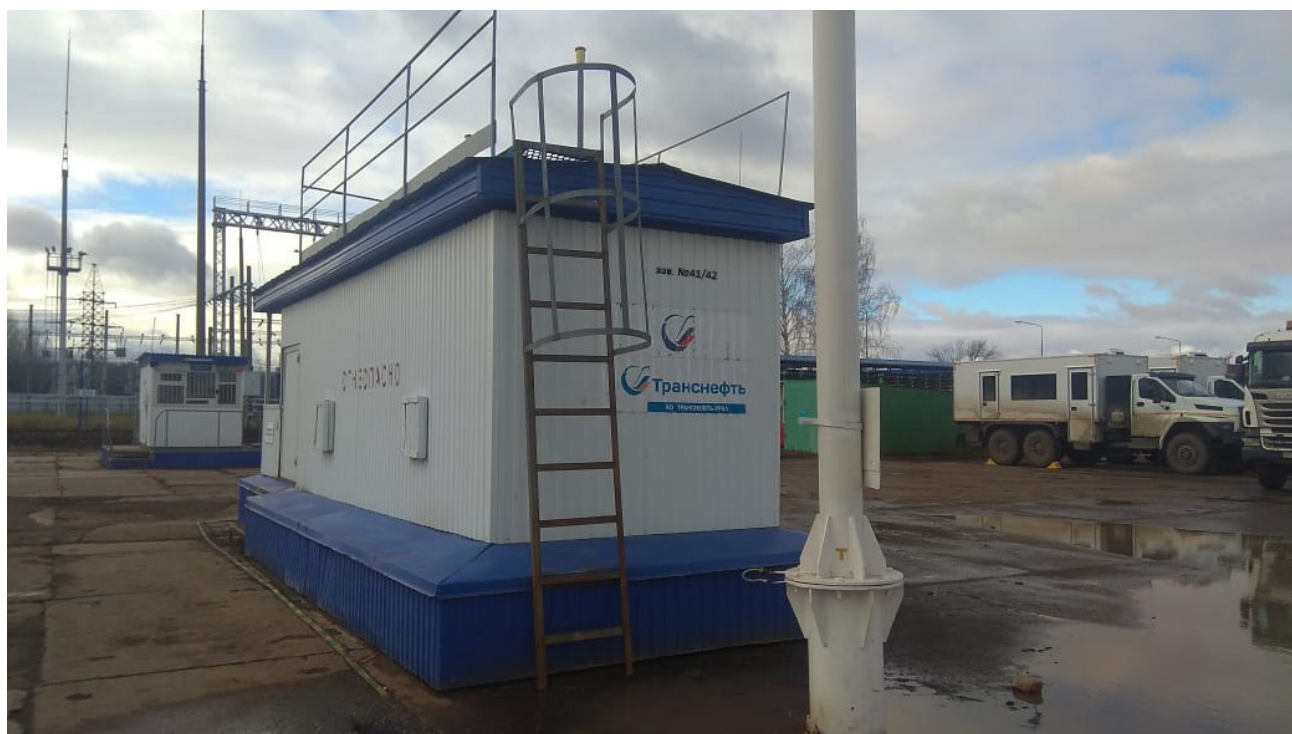
Рисунок 2 – Общий вид резервуара РС-20
