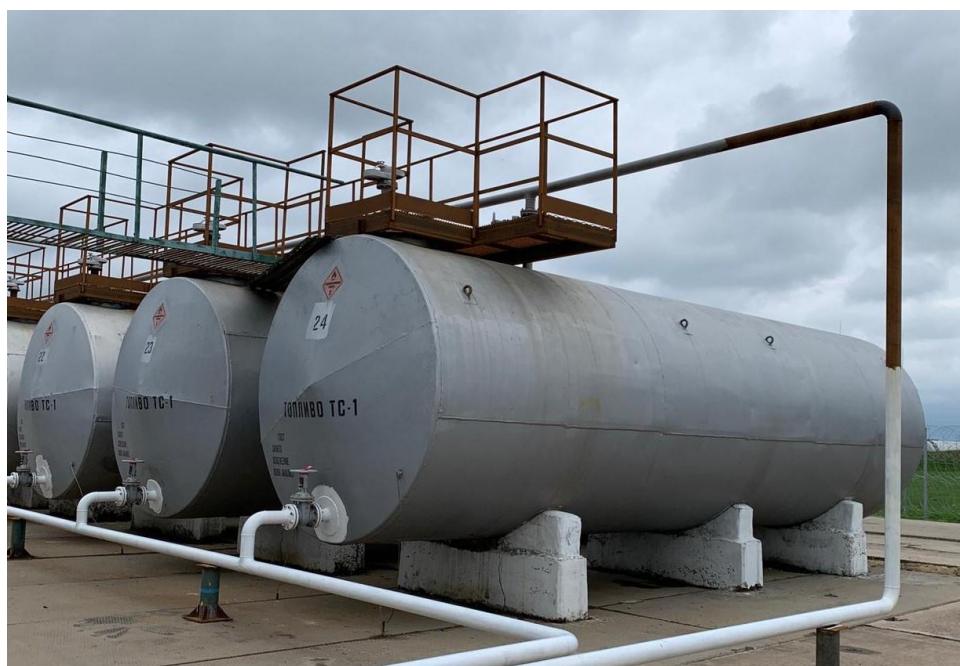
Рисунок 1 – Общий вид резервуаров РГС-50
