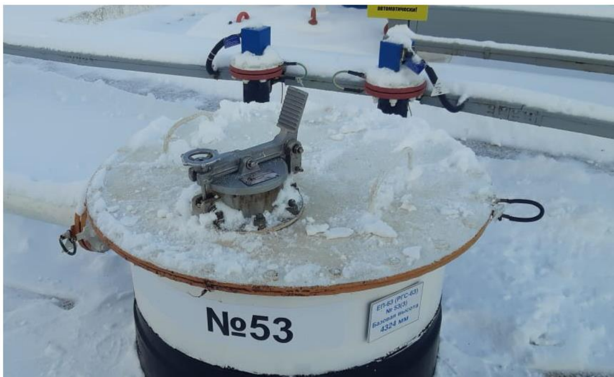
Рисунок 2 – Общий вид резервуара РГС-63 с заводским номером 53
