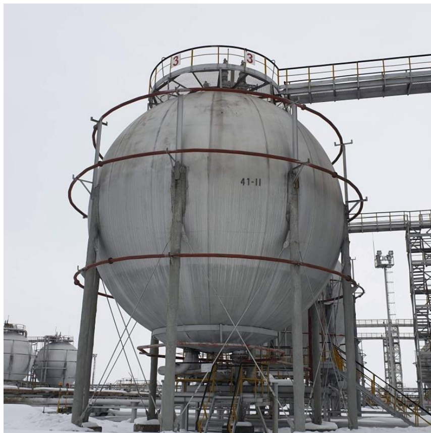
Рисунок 2 – Общий вид резервуаров РШС-600
