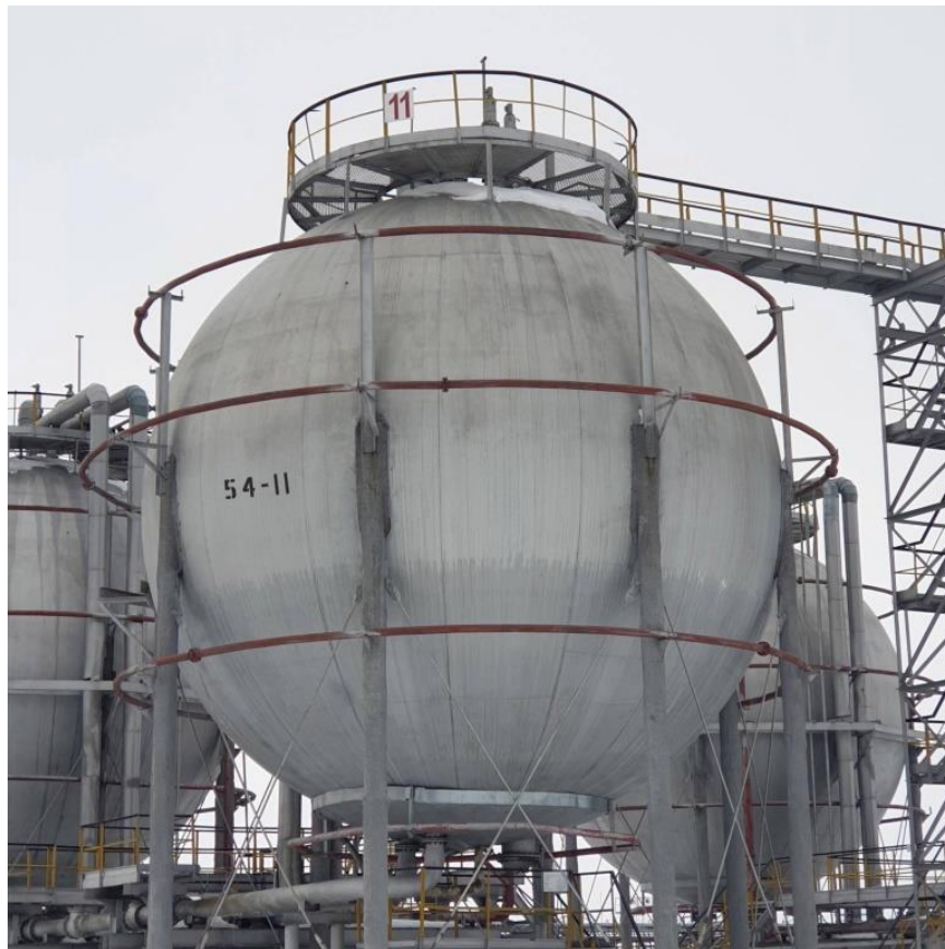
Рисунок 10– Общий вид резервуаров РШС-600
