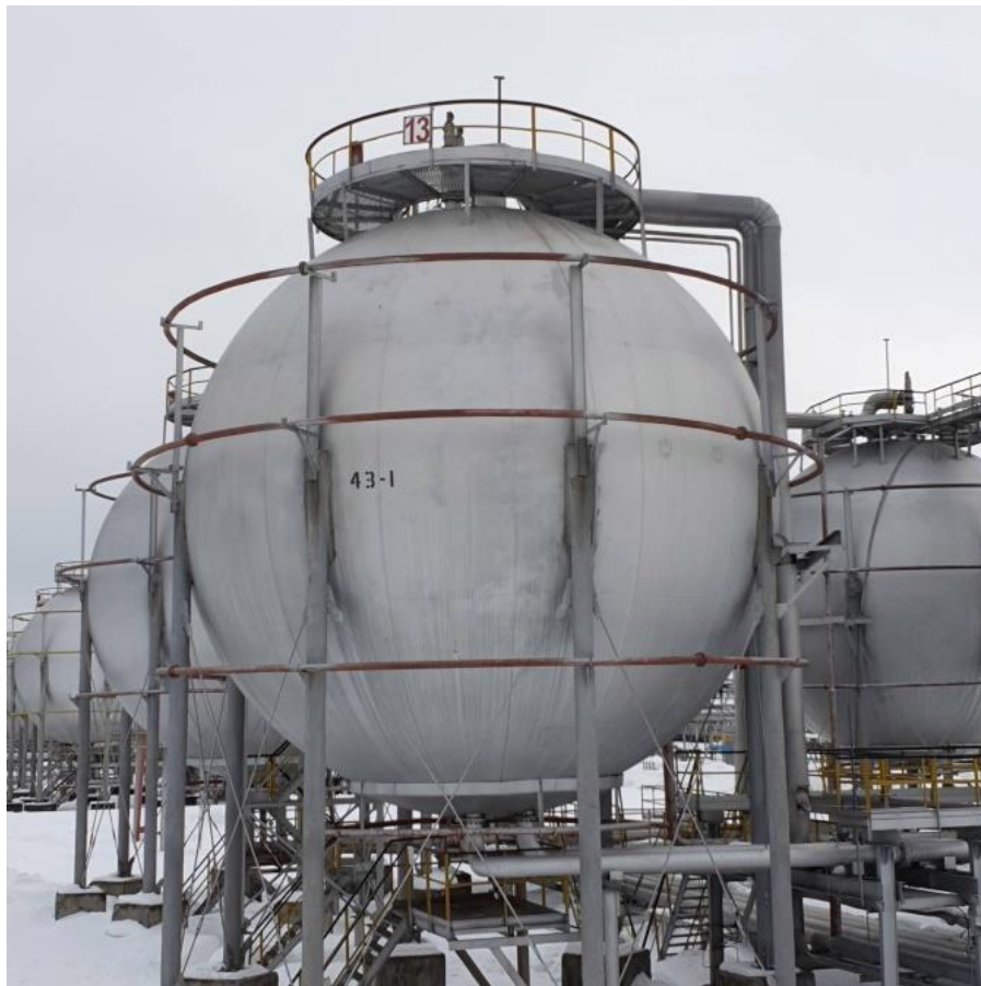
Рисунок 5– Общий вид резервуаров РИС-600
