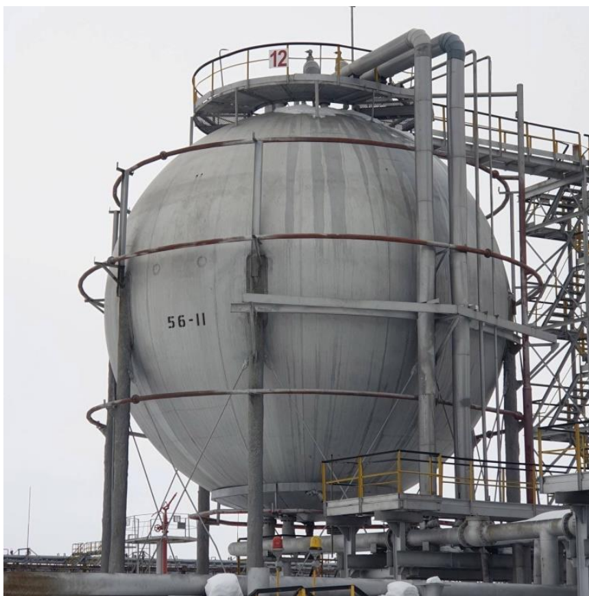
Рисунок 12– Общий вид резервуаров РШС-600
