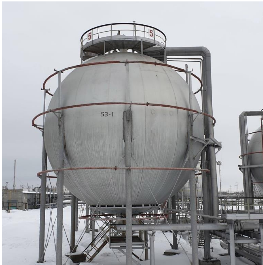
Рисунок 7– Общий вид резервуаров РШС-600
