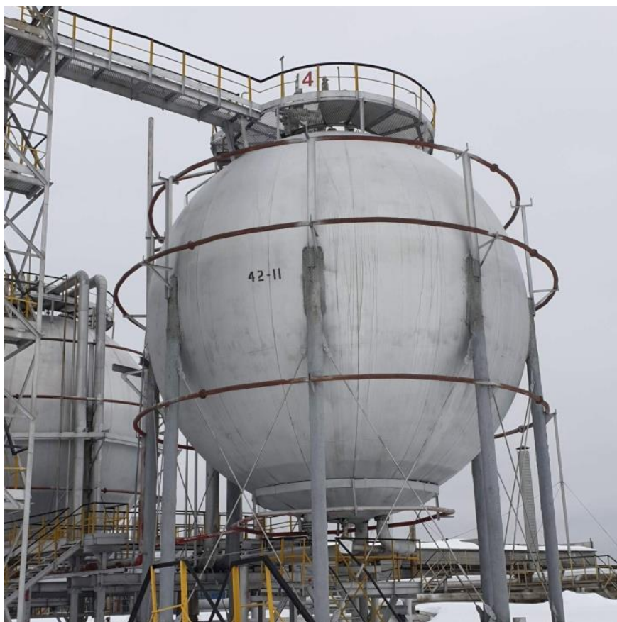
Рисунок 4– Общий вид резервуаров РШС-600
