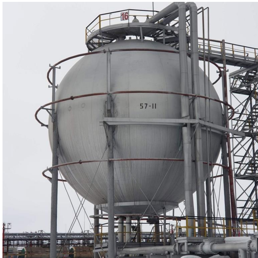
Рисунок 14– Общий вид резервуаров РШС-600
