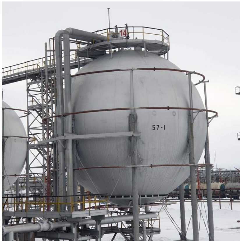
Рисунок 13– Общий вид резервуаров РШС-600
