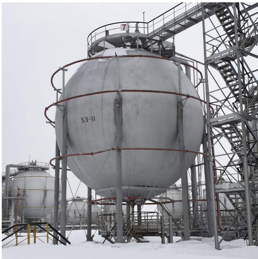
Рисунок 8– Общий вид резервуаров РШС-600
