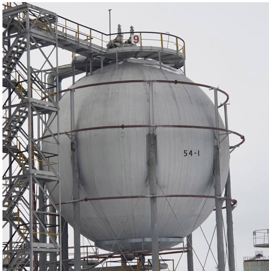
Рисунок 9– Общий вид резервуаров РШС-600
