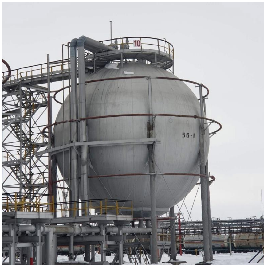
Рисунок 11– Общий вид резервуаров РШС-600
