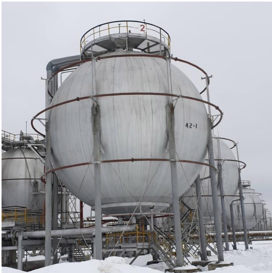
Рисунок 3– Общий вид резервуаров РШС-600
