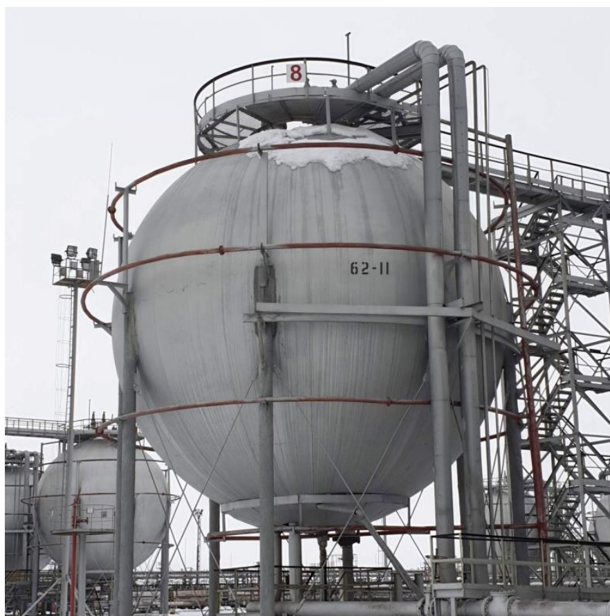
Рисунок 16– Общий вид резервуаров РШС-600
