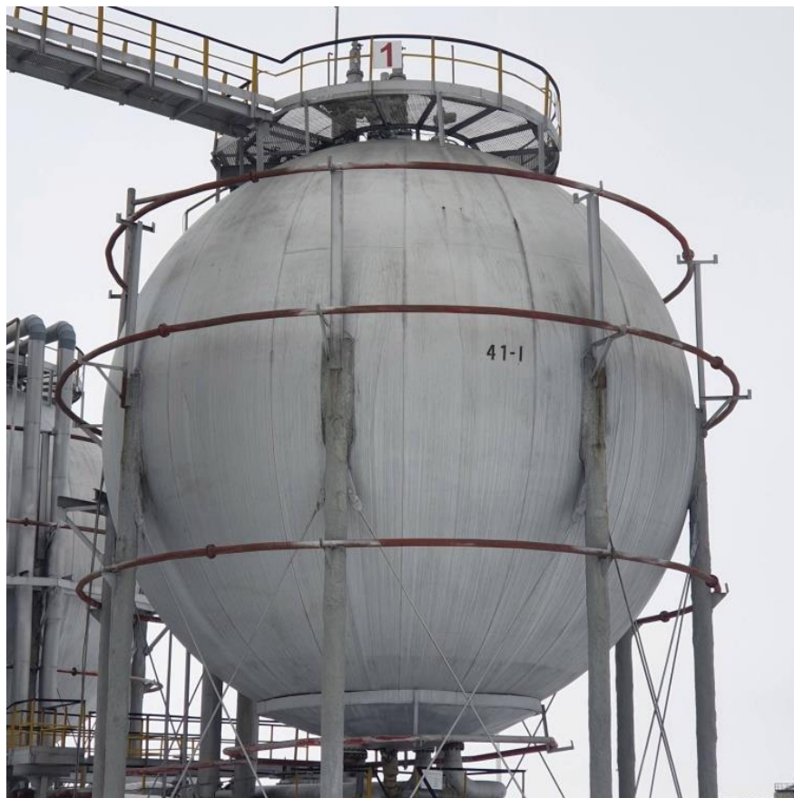
Рисунок 1 – Общий вид резервуаров РШС-600
