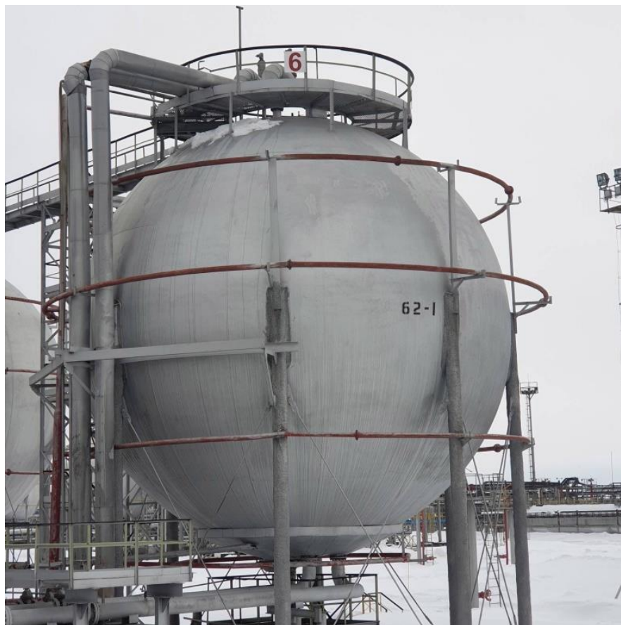
Рисунок 15– Общий вид резервуаров РШС-600
