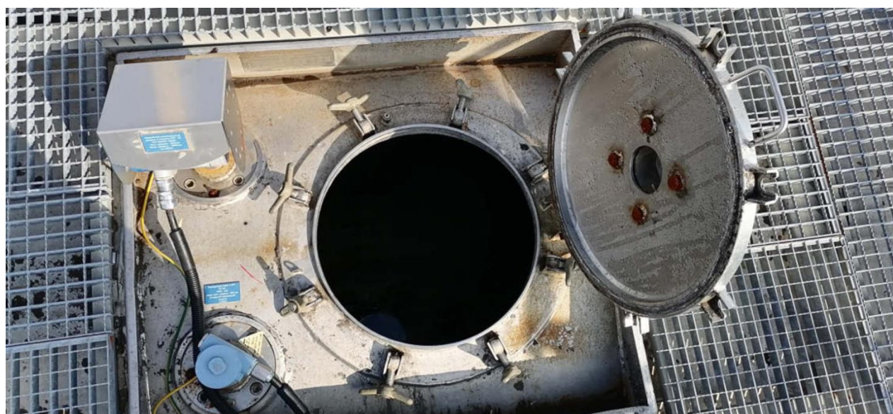
Рисунок 2 – Общий вид резервуара РГС-24
