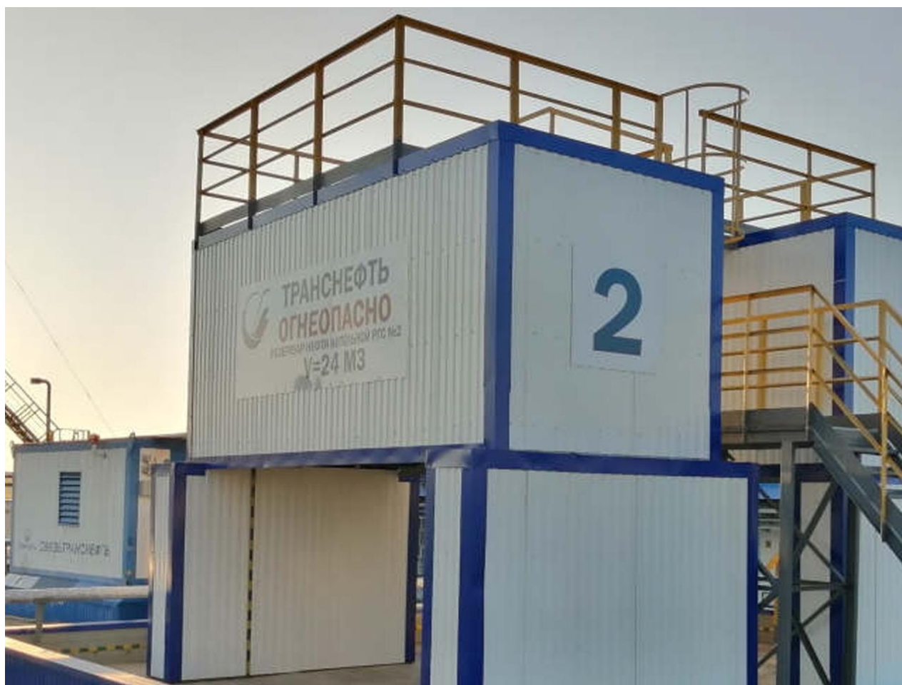
Рисунок 1 – Общий вид резервуара РГС-24
