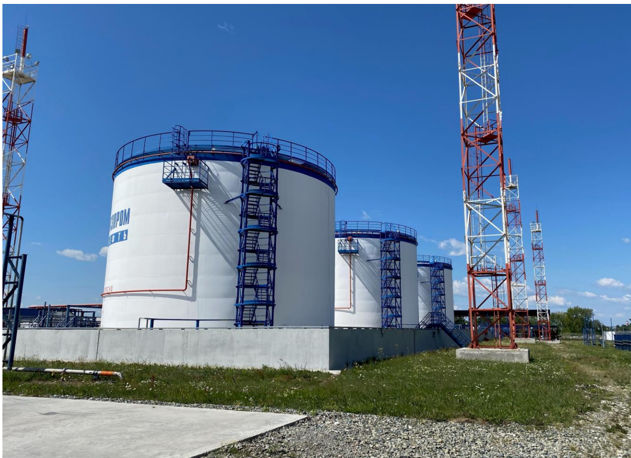
Рисунок 2 – Общий вид резервуаров РВС-3000
