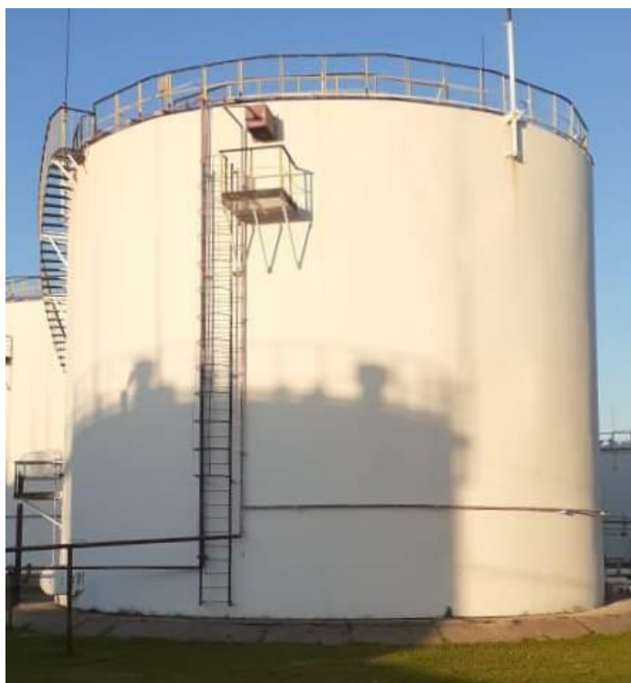
Рисунок 4 – Общий вид резервуаров РВСП-2000
