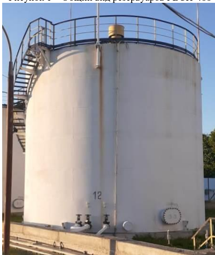
Рисунок 2 – Общий вид резервуаров РВСП-700
