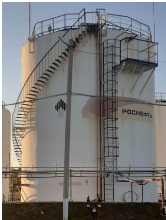
Рисунок 3 – Общий вид резервуаров РВСП-1000
