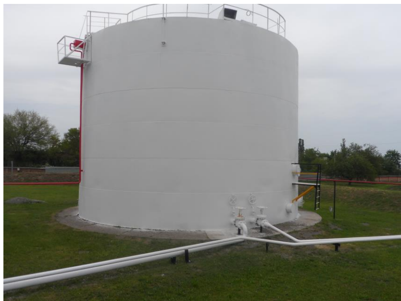
Рисунок 3 – Общий вид резервуаров РВСП-1000
