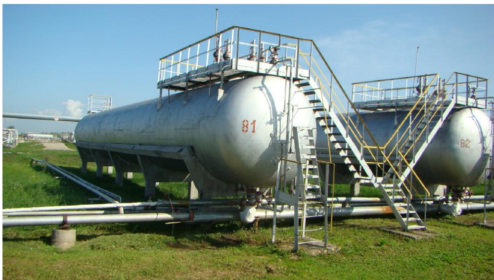
Рисунок 1 - Общий вид резервуаров стальных горизонтальных цилиндрических РГС-175
