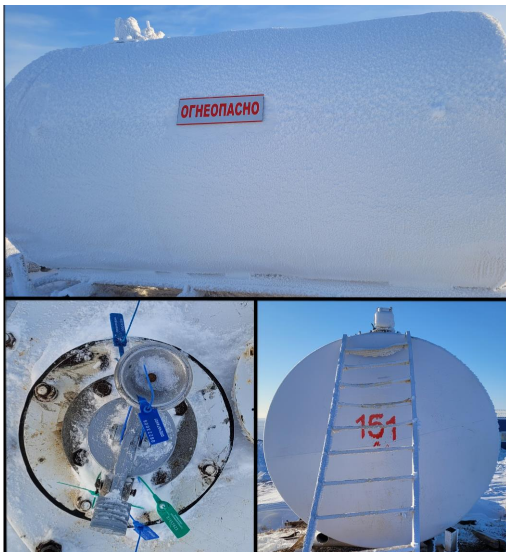
Рисунок 1 - Общий вид резервуара РГС-25 №151
