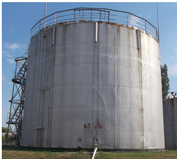
Рисунок 2 – Общий вид резервуаров РВС-1000
