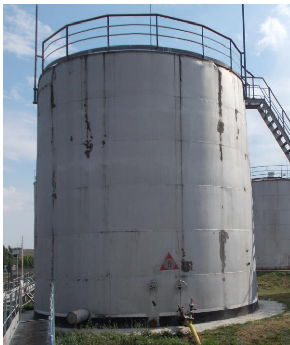
Рисунок 1 – Общий вид резервуаров РВС-400
