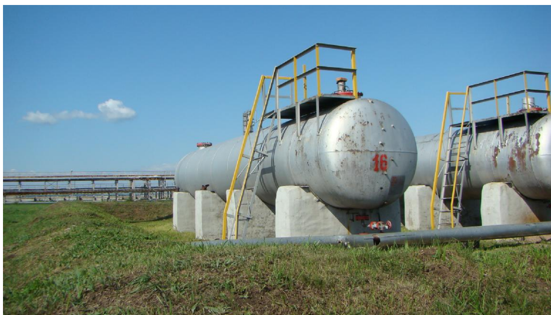
Рисунок 1 - Общий вид резервуаров стальных горизонтальных цилиндрических РГС-49
