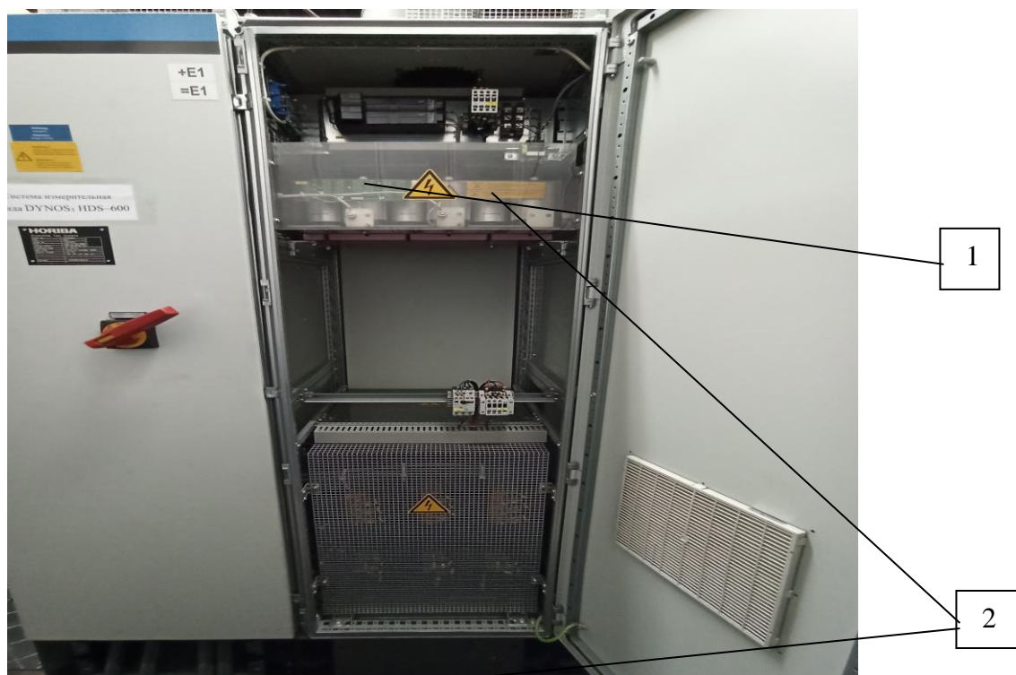
Рисунок 3 - Инверторный кабинет- электрошкаф асинхронной машины DYNAS 3 HDS-600 с отсеками E1, D1, G1-G3. Общий вид
