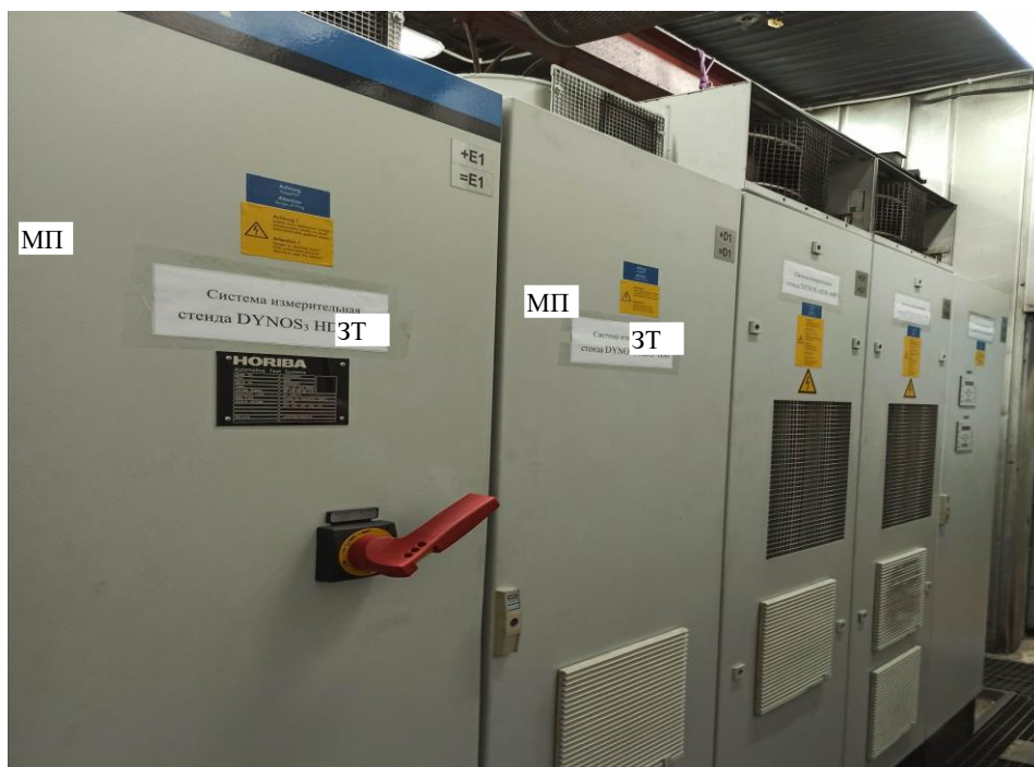
Рисунок 3 - Инверторный кабинет- электрошкаф асинхронной машины DYNAS 3 HDS-600 с отсеками E1, D1, G1-G3. Общий вид
