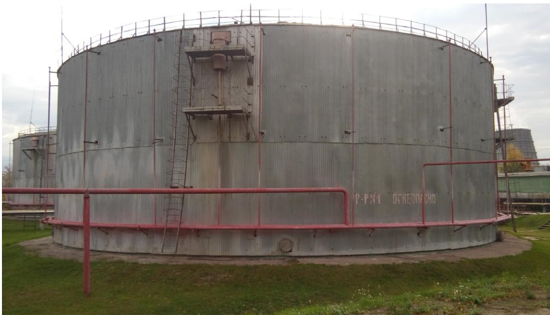
Рисунок 1 - Общий вид резервуара стального вертикального цилиндрического РВС-10000 № 1
