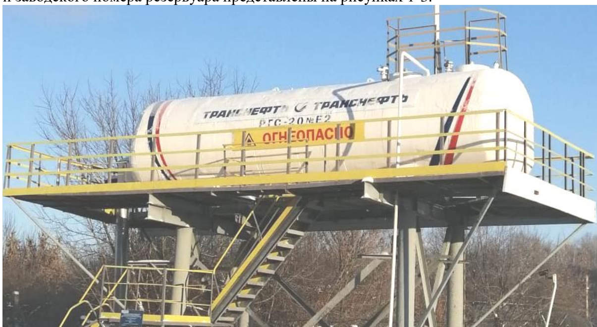
Рисунок 1 – Общий вид резервуара горизонтального стального цилиндрического РГС-20 зав. № Е-2/20/Б
