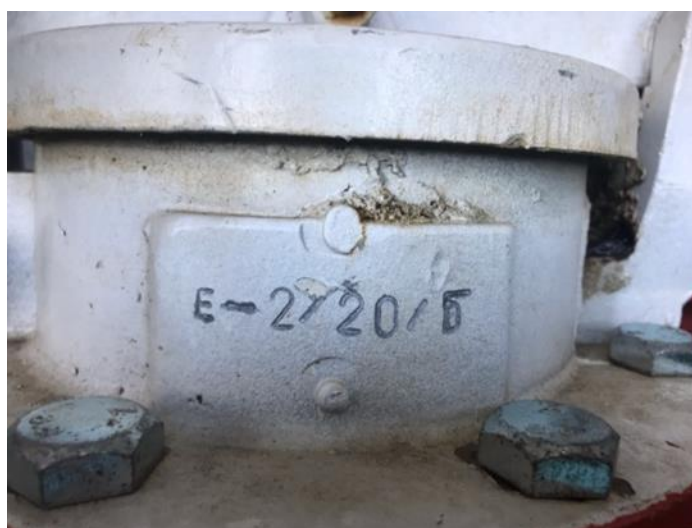
Рисунок 3 – Фотография заводского номера резервуара РГС-20 зав. № Е-2/20/Б
