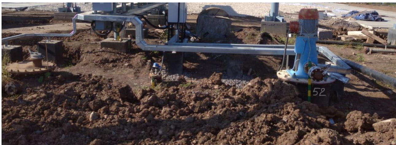
Рисунок 1 – Общий вид резервуара РГС-40 с заводским номером 52
