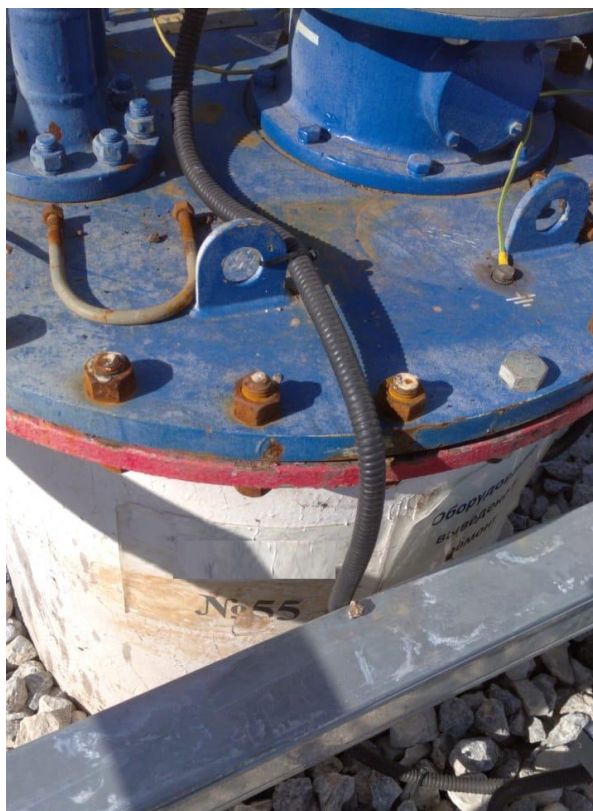
Рисунок 2 – Общий вид резервуара РГС-40 с заводским номером 55
