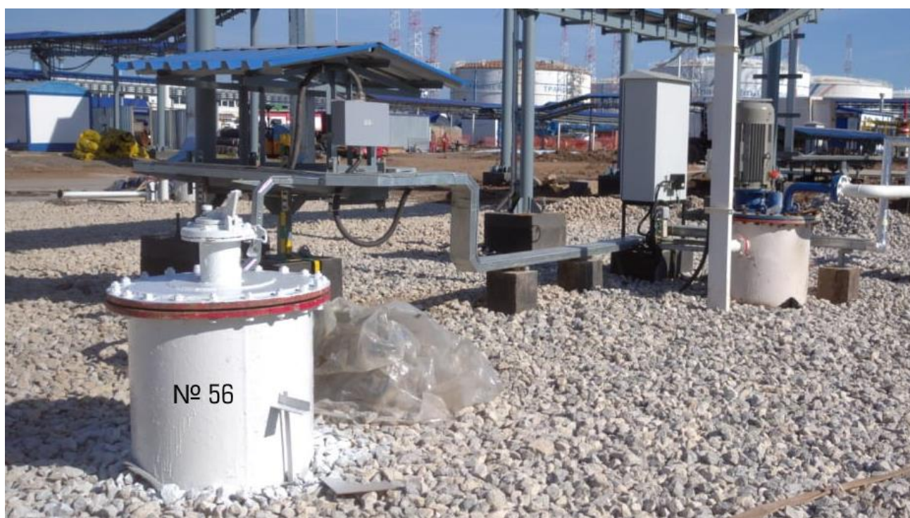
Рисунок 3 – Общий вид резервуара РГС-40 с заводским номером 56
