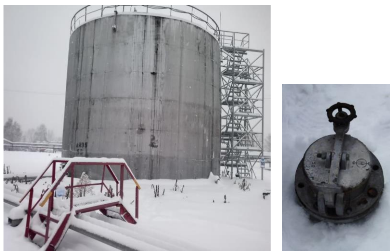
Рисунок 1 – Общий вид резервуара с заводским номером 55 и замерного люка Нанесение знака поверки на резервуар не предусмотрено. Пломбирование резервуара не предусмотрено.
