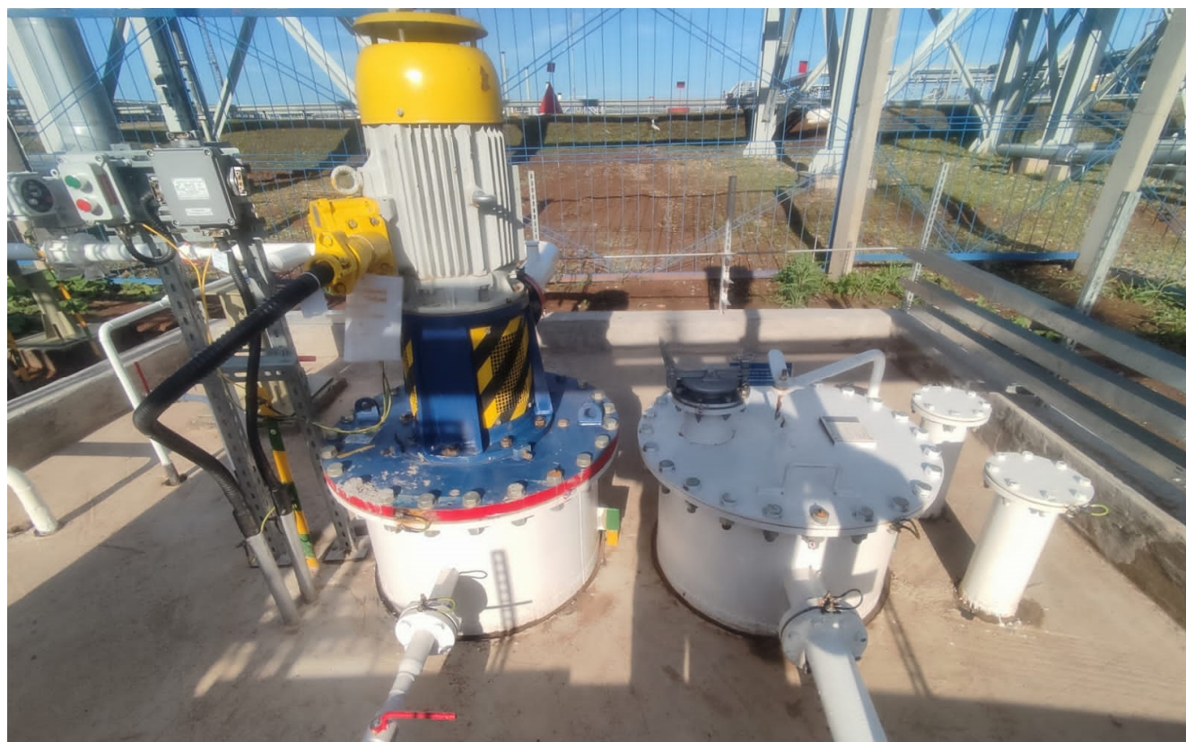
Рисунок 2 – Общий вид резервуара ЕП-5-1600-600-А-С-У1
